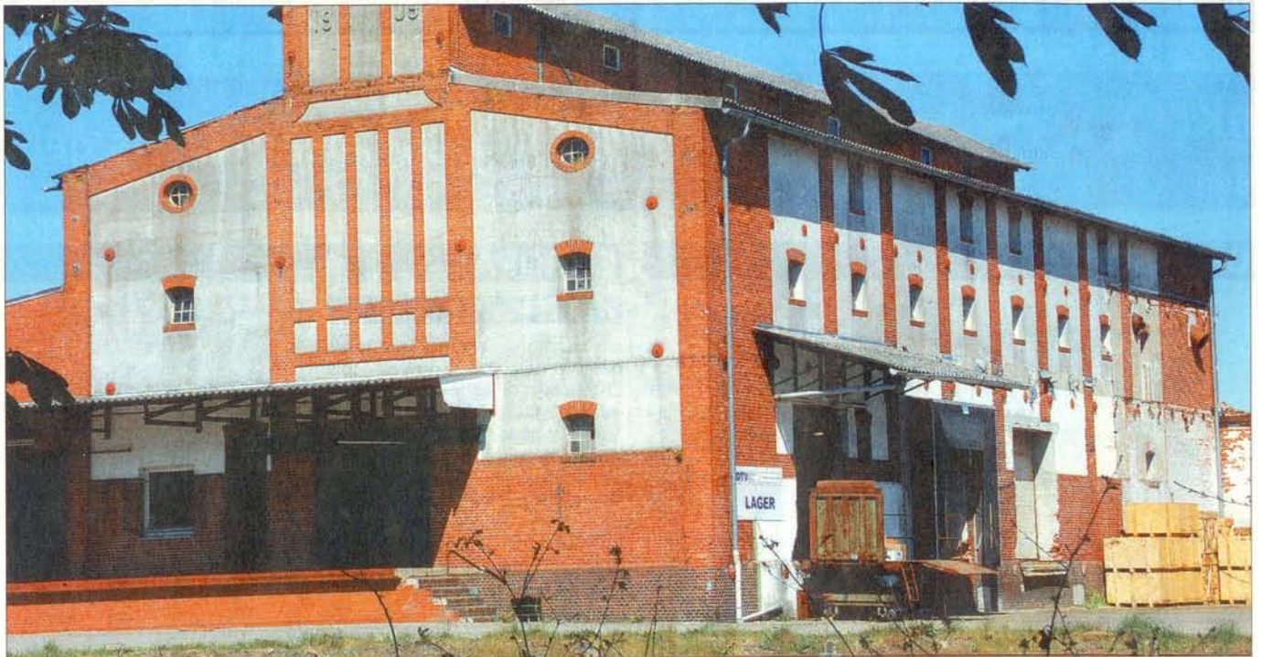
Die Firma OTV will in den GewerbePark Rheiderland umsiedeln. Derzeit befindet sich der Sitz des Unternehmens am Leege Weg in Bunde, wo die Lagerhalle und das Bürogebäude des ehemaligen Saatgut-Handels Pehle & Beckmann genutzt werden (Foto). Foto; Hanken
